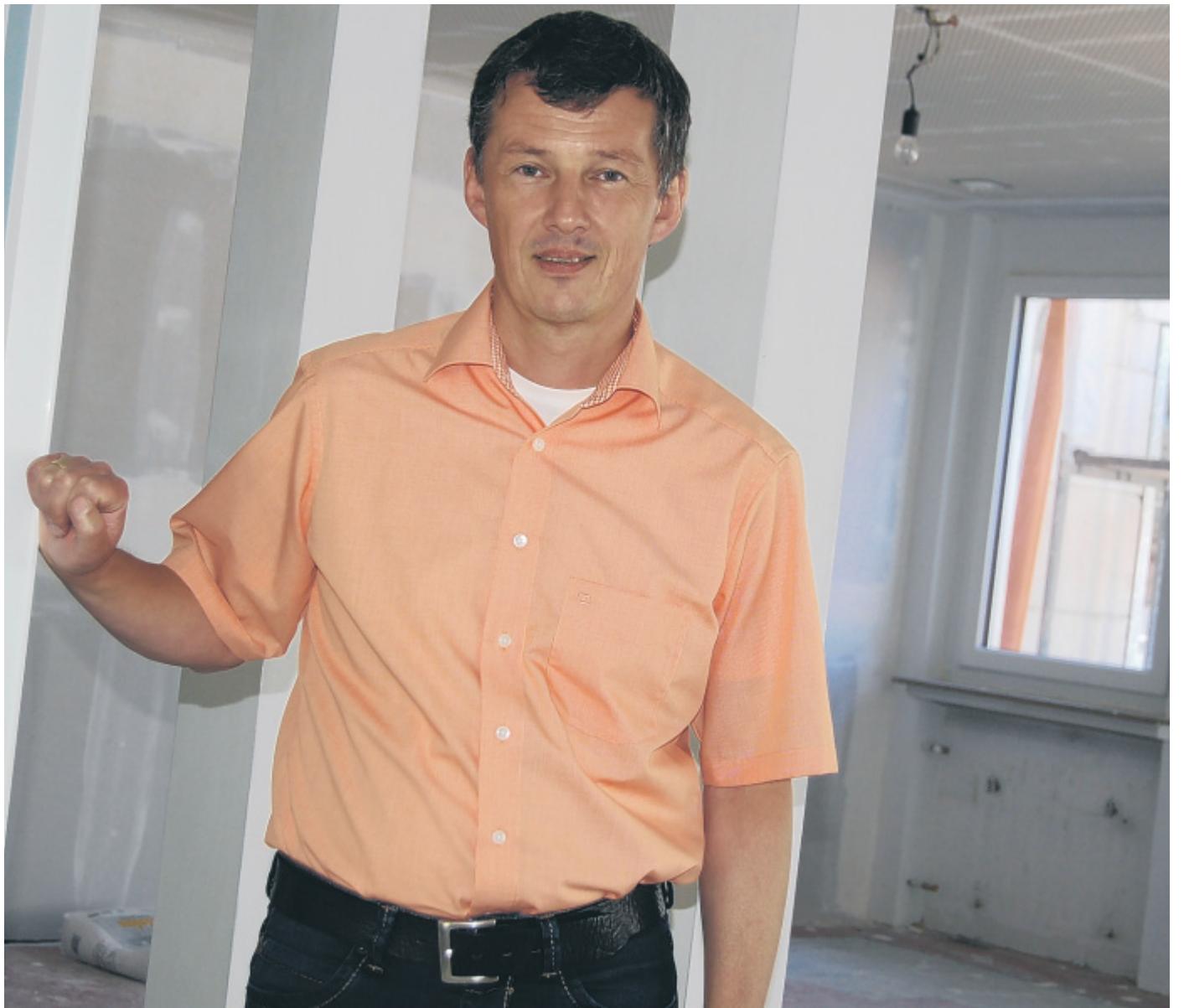
Bauarbeiten: Nach dem Umbau wird das Rathaus barrierefrei zugänglich sein. Ein überfälliger Schritt, findet Bürgermeister Bernd Dumcke, hier im zukünftigen Bürgerbüro. FOTO: CAROLA RITTERHOFF
